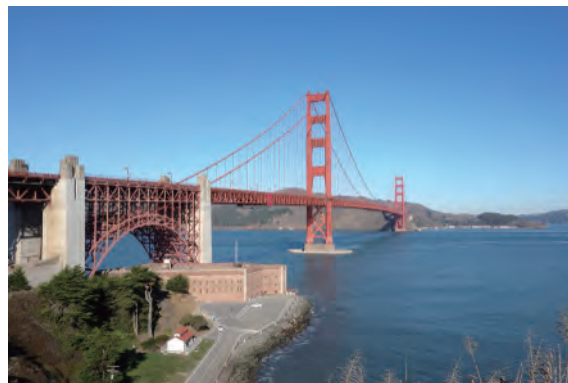
インフラの計画・設計・施工・維持管理によって国を支える
